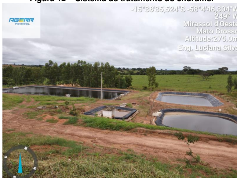
Figura 12 – Sistema de tratamento do chorume.
