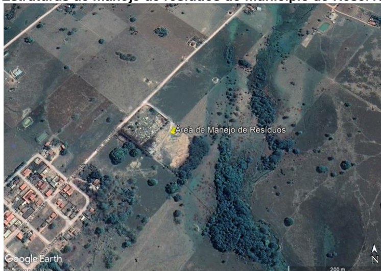
Figura 16 – Estruturas de manejo de resíduos do município de Reserva do Cabaçal.
