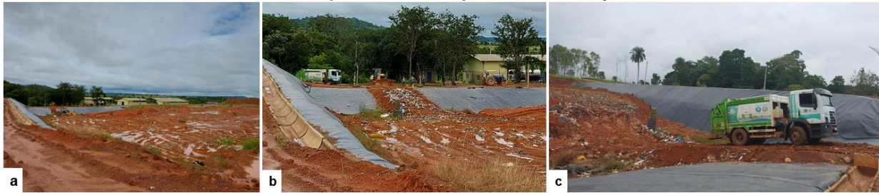
Figura 9 – Célula II do aterro sanitário: a) Vista geral da célula II; b) Rampa de acesso dos caminhões; c) Caminhão depositando os rejeitos.
