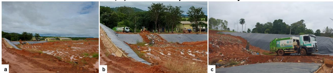
Figura 9 – Célula II do aterro sanitário: a) Vista geral da célula II; b) Rampa de acesso dos caminhões; c) Caminhão depositando os rejeitos.
