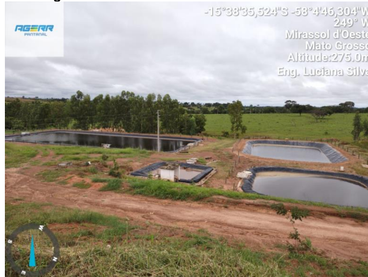
Figura 12 – Sistema de tratamento do chorume.
