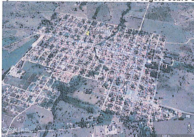
Figura 15: Localização da travessia da rede coletora de esgoto sobre o Córrego da Saúde
